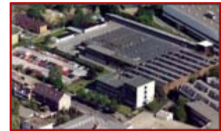
Abbildung 1: Firmengebäude Reiners + Fürst in Mönchengladbach
